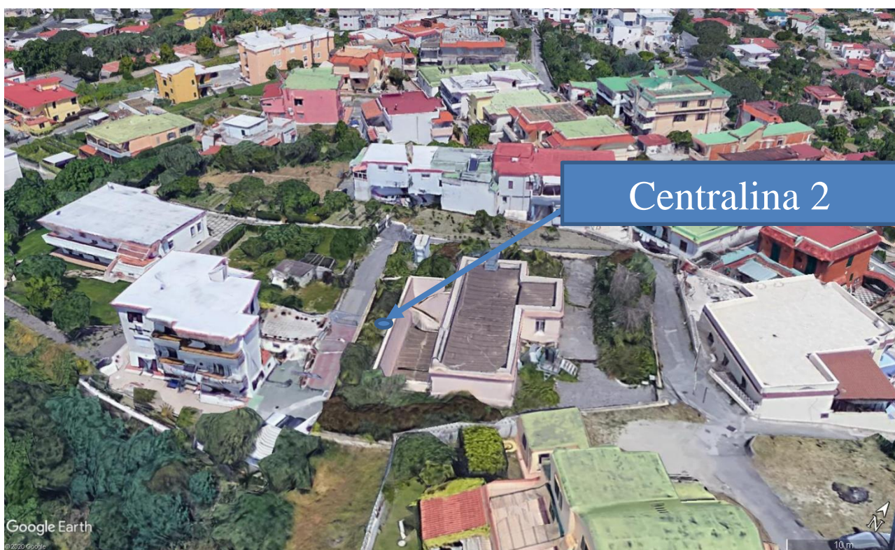
Figura 4. Vista aerea del luogo di installazione della “Centralina 2”.
